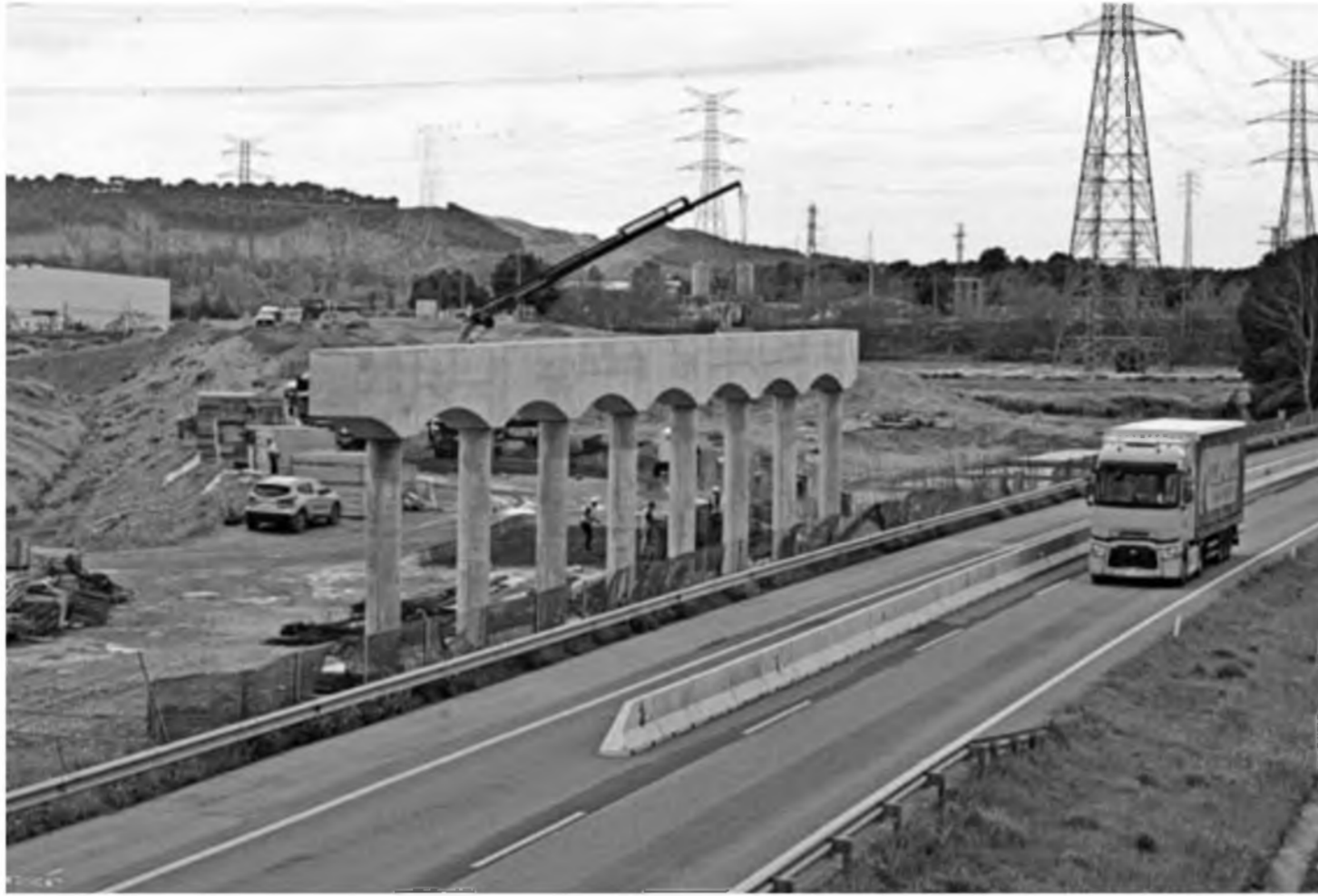
Obras del TAV en el término de Marcilla, en una imagen del pasado mes de abril.
